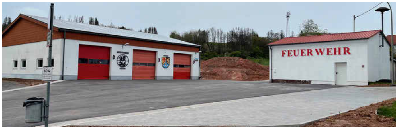
Der nun befestigte Vorplatz des Feuerwehrhaus in Eckelhausen mit den neuen Parkplätzen / Foto: Gde Nohfelden
