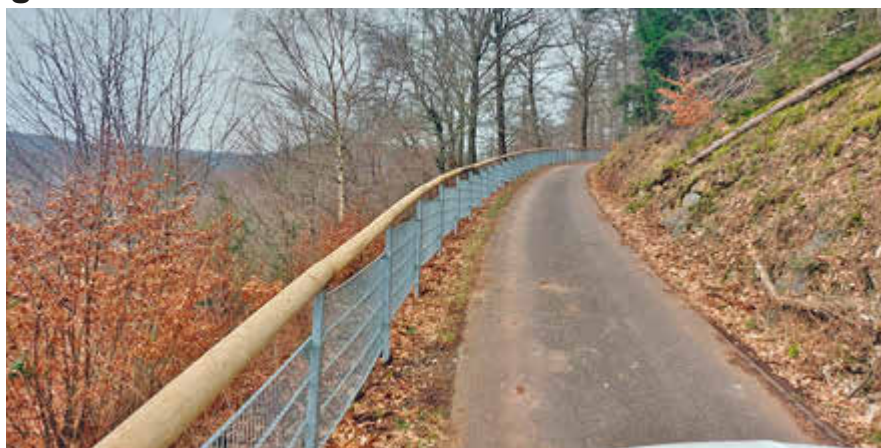
Das neue Geländer entlang des Naheradweg im Rosenwald zwischen Nohfelden und Neubrücke / Foto: Gemeinde Nohfelden
