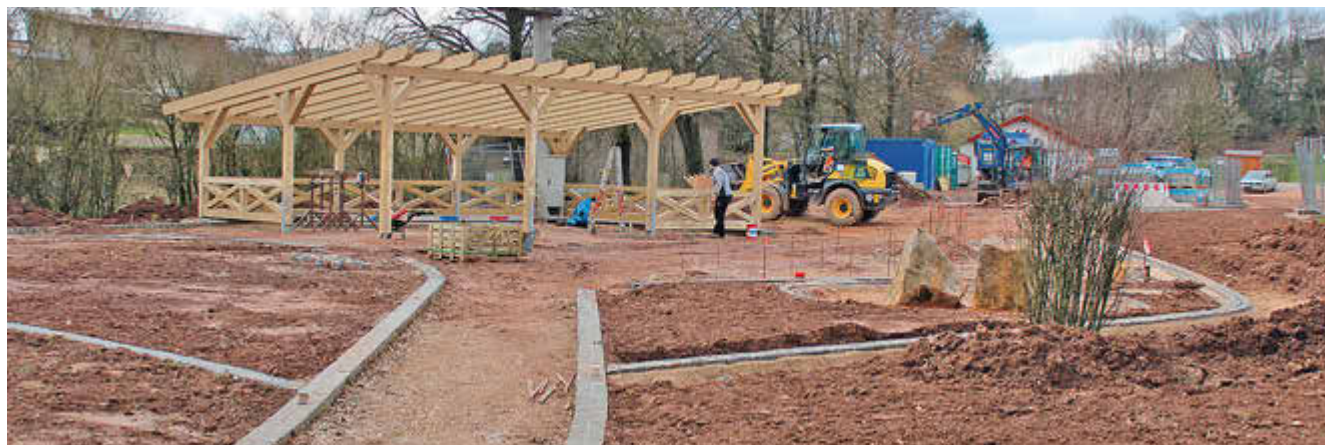
Die Baustellen in Eckelhausen und Selbach / Foto: Gemeinde Nohfelden
