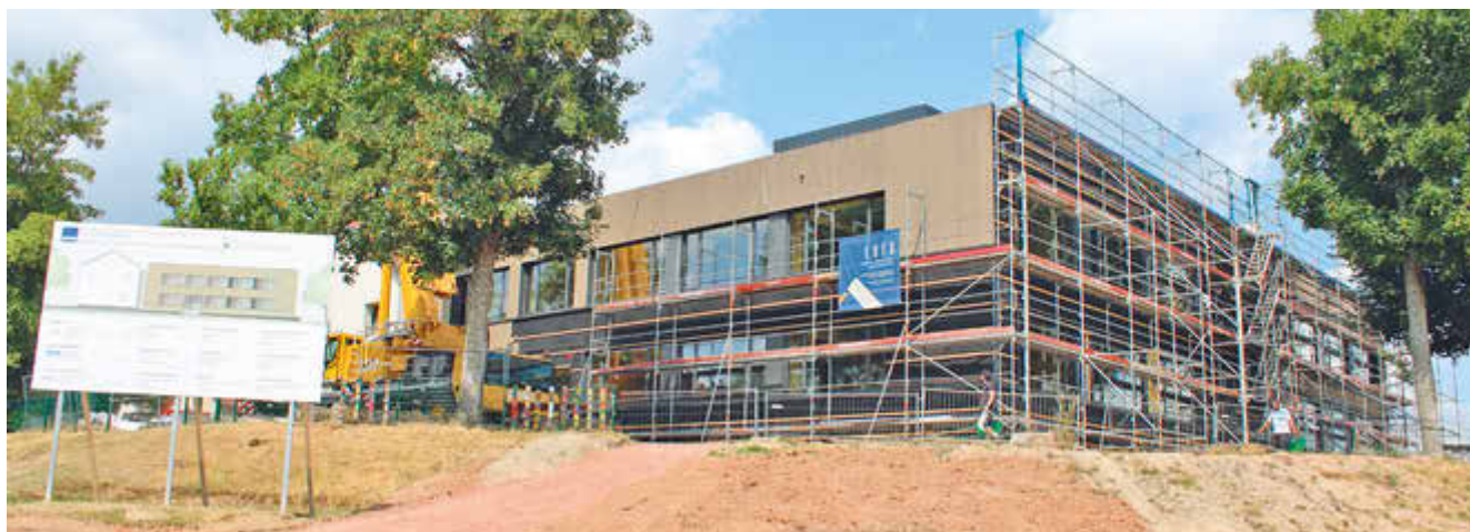
Ein Großteil der getätigten Investitionen wird in den Bereich Bildung fließen, hier der Ersatzneubau am Grundschulstandort in Sötern / Foto: Gemeinde Nohfelden
