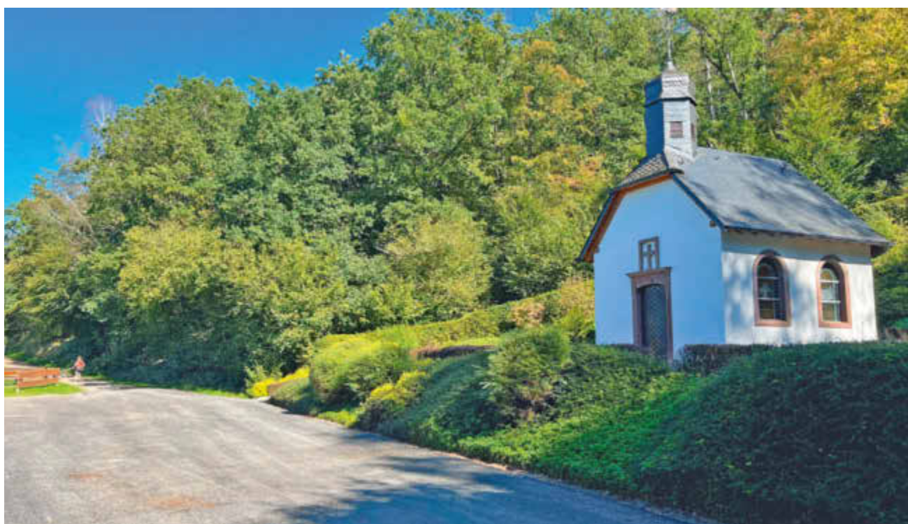
Der Zuweg zur Kapelle vom Vereinsplatz wurde neu asphaltiert / Fotos: Gemeinde Nohfelden
