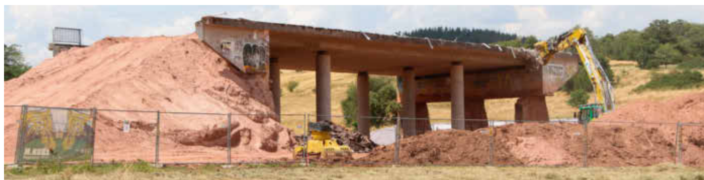
Aktuell dauern die Arbeiten an der Soda-Brücke noch an / Fotos: Gemeinde Nohfelden
