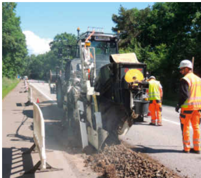
Für das Verlegen der Leerrohre zwischen den Orten kommt diese Maschine zum Einsatz. / Foto: Gemeinde Nohfelden
