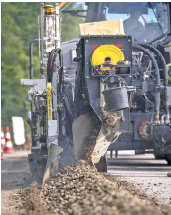
Verlegung des Kabels mit Fräsen und Wiederauffüllen in einem Arbeitsschritt / Foto: atene KOM / Florian Schuh
