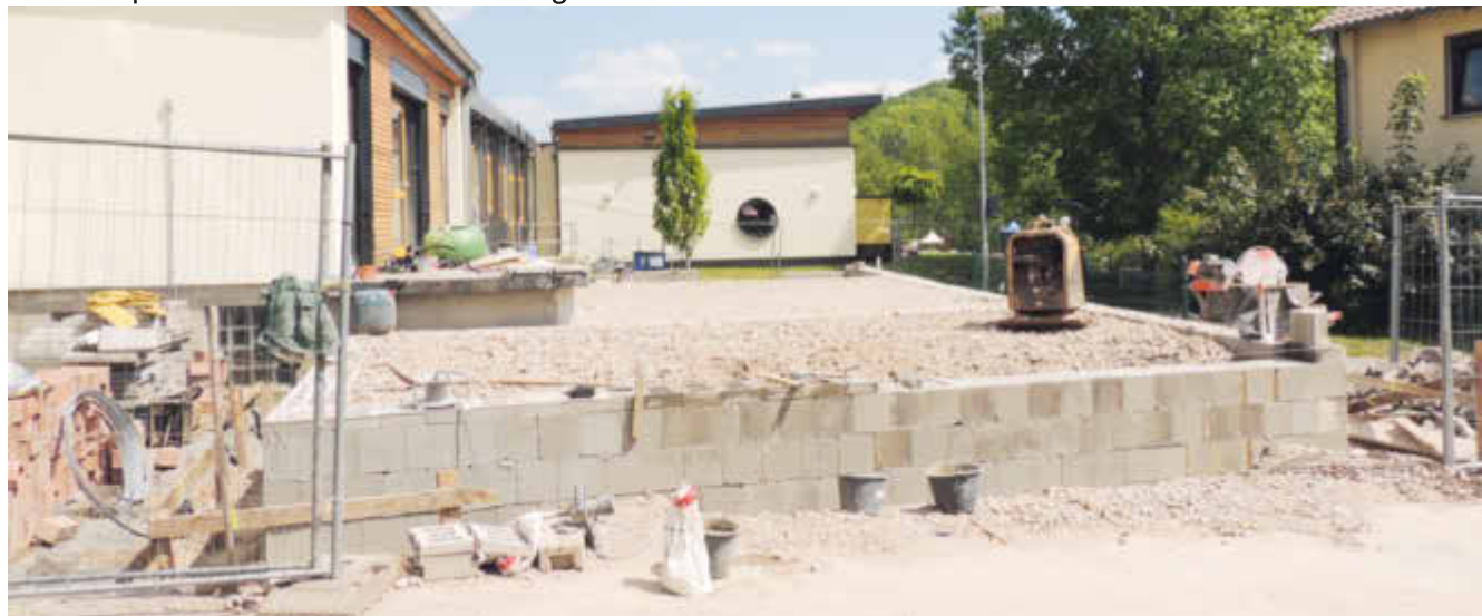
Nach Ende der Maurerarbeiten wird die Bodenplatte für den neuen Gruppenraum gesetzt / Foto: Gemeinde Nohfelden
