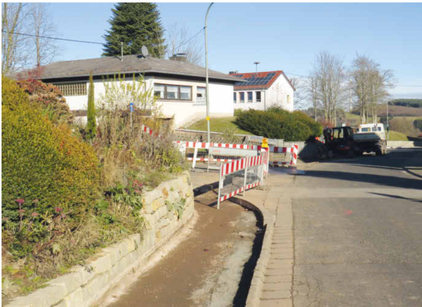
In Sötern erfolgt das Verlegen des Glasfaserkabels parallel mit dem Bau des neuen Stromanschlusses / Foto: Gem. Nohfelden
