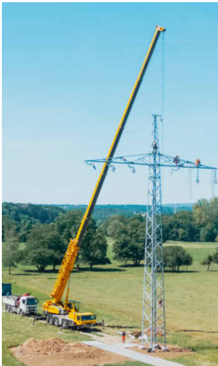
Aufstellen der neuen Masten / Foto: VSE
