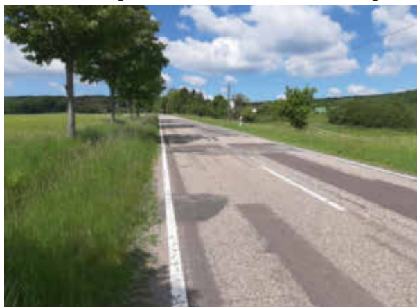
Fahrbahninstandsetzung der L326, Photo: Gemeinde Nohfelden
