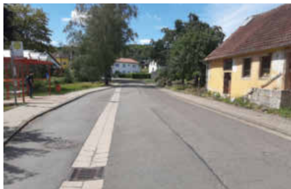
In der Brückenstraße und Im Hirzenbruch in Bosen werden neben der Asphaltdecke auch die Rinnenanlage und die Gehwege instand gesetzt.
