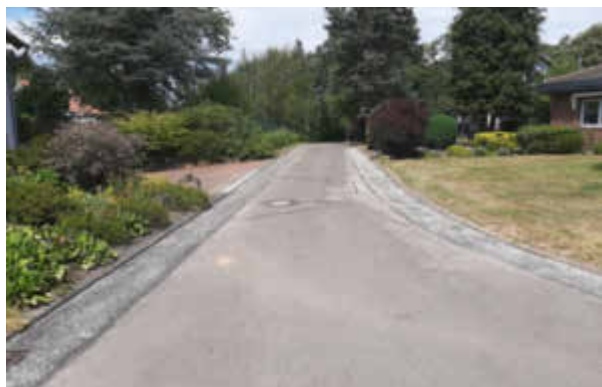
Die Arbeiten in der Hubert-Schmidt-Straße in Türkismühle sind bereits abgeschlossen. Hier wurden die schadhaften Rinnenplatten entfernt und durch Asphalt ersetzt.
